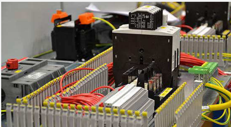
Pannello Quadro in lavorazione
